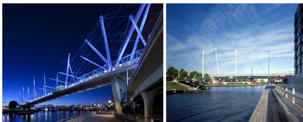
Рисунок 2. Мостовые сооружения типа тенсегрители: Курилпа Бридж(слева) в Австралии и мост в г. Алмере (Нидерланды) (справа)
