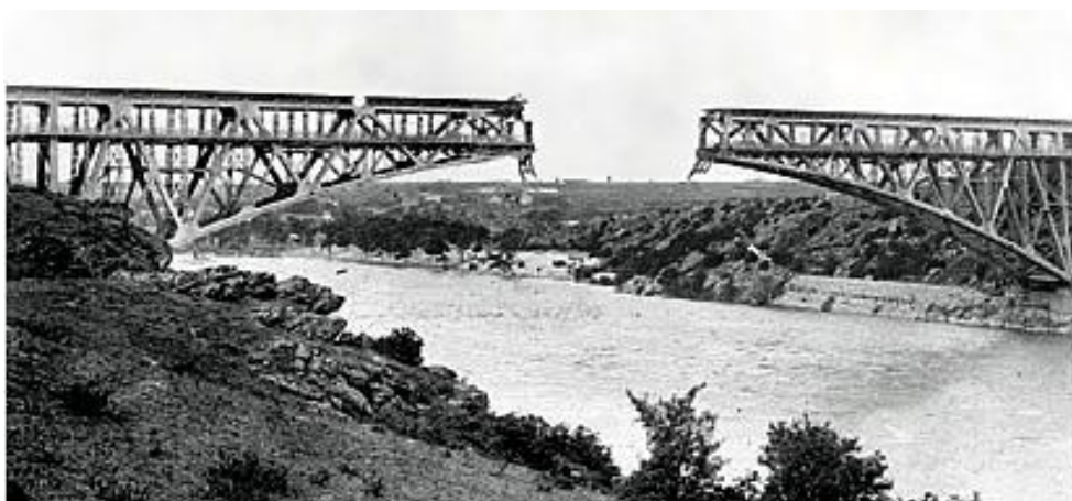
Рисунок 12. Разрушенный Кичкасский мост [7]
