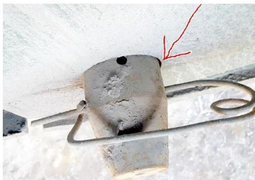
*Рисунок 6. Повышенный зазор в штыревом соединении секций пролетного строения САРМ (разработано автором)*
