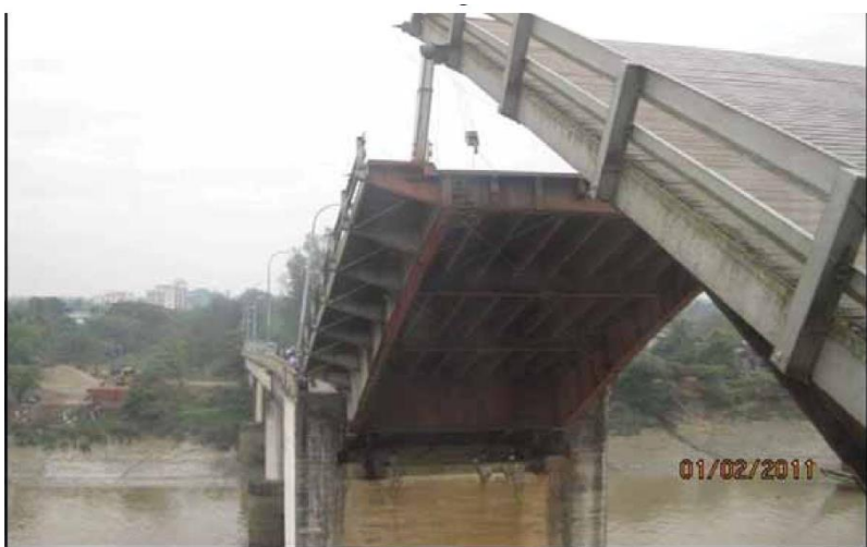
Рисунок 6. Разводной мост (фото авторов)
