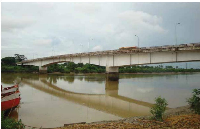
Рисунок 4. Рамный мост через реку Хлаинг (фото авторов)
