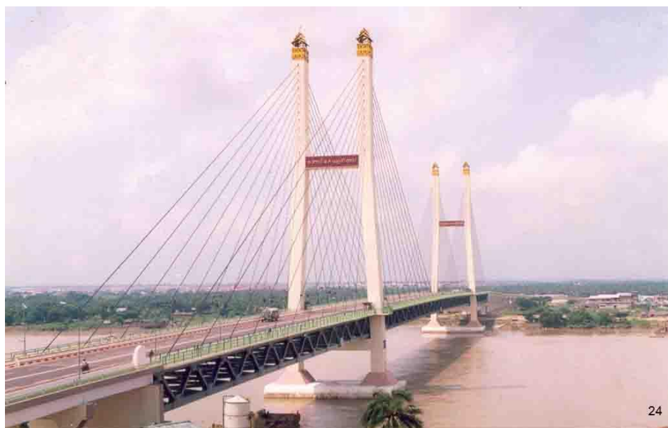
Рисунок 9. Вантовый мост Аундг Зайяр (фото авторов)
