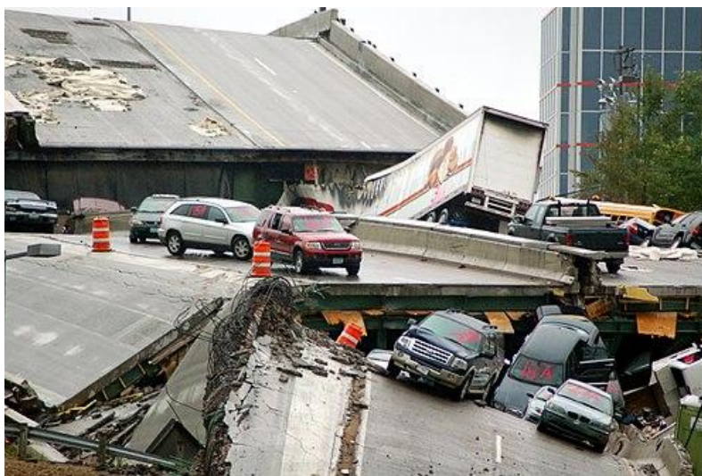
Рисунок 2. Рухнувший мост I-35W через Миссисипи 2
