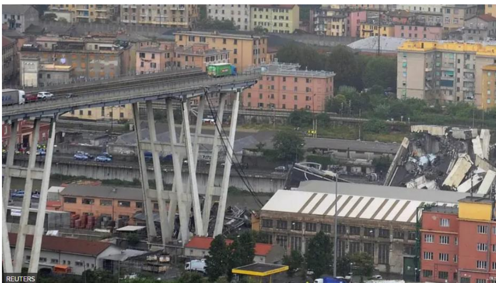
Рисунок 1. Разрушенный мост Моранди в Генуе 1
