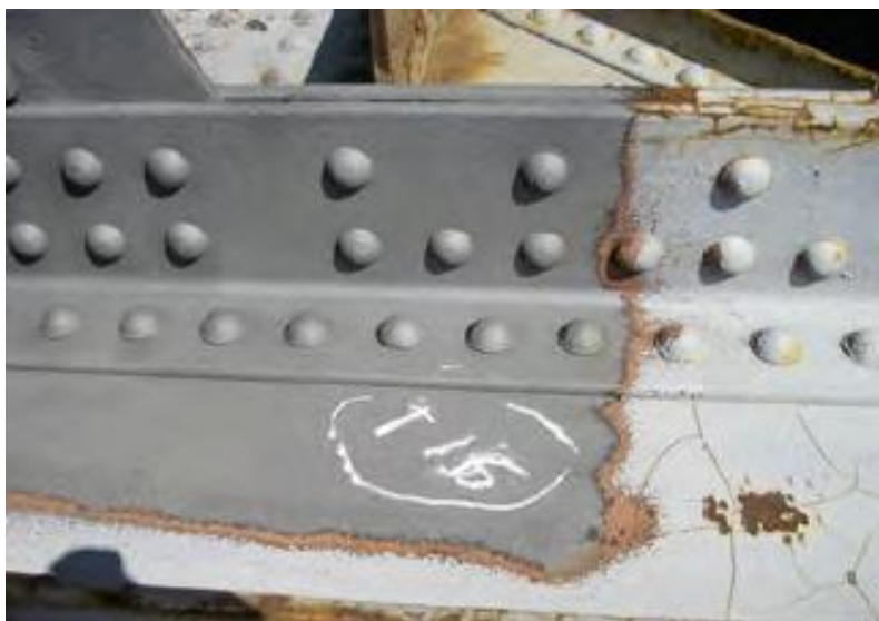
Рисунок 6. Фрагмент металлической конструкции после обработки абразивоструйным методом (источник: [1])
