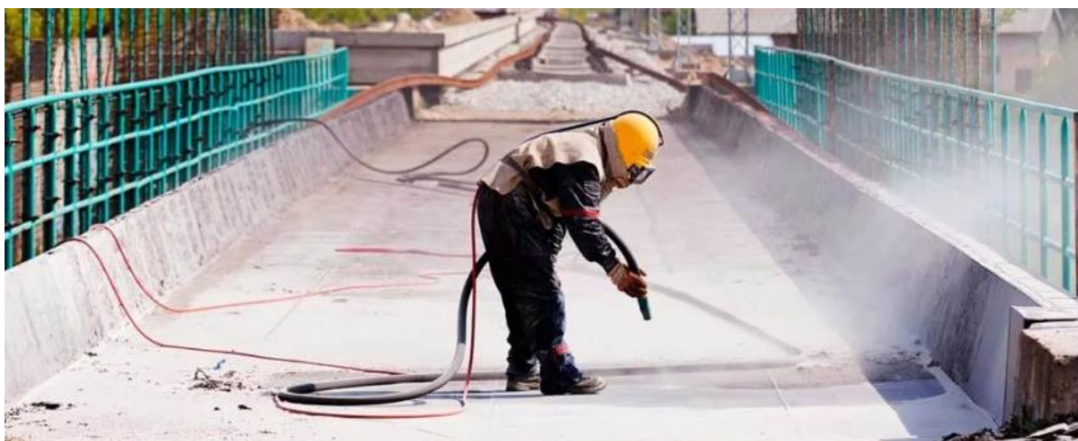
Рисунок 2. Струйная очистка поверхности мостового сооружения (источник: https://vacublast.com.au/ )
