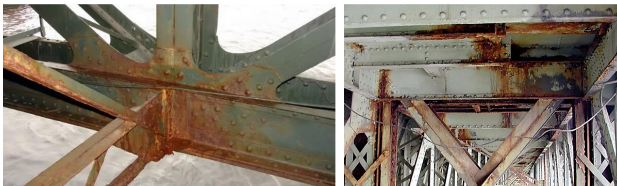
Рисунок 1. Поражение конструкций моста коррозией, причиной которого возможно стало нарушение одного из этапов нанесения защитного покрытия: а) источник: https://izyskaniya-obsledovanie.ru/ ; б) источник: [5]
