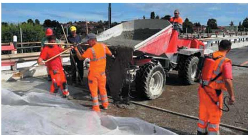
**Рисунок 8.** Укладка слоя из UHPFRC. Мост в Швейцарии. Восстановление и гидроизоляция всей плиты и карнизов <https://www.dorvest.ru/dd/newnumber.html>
