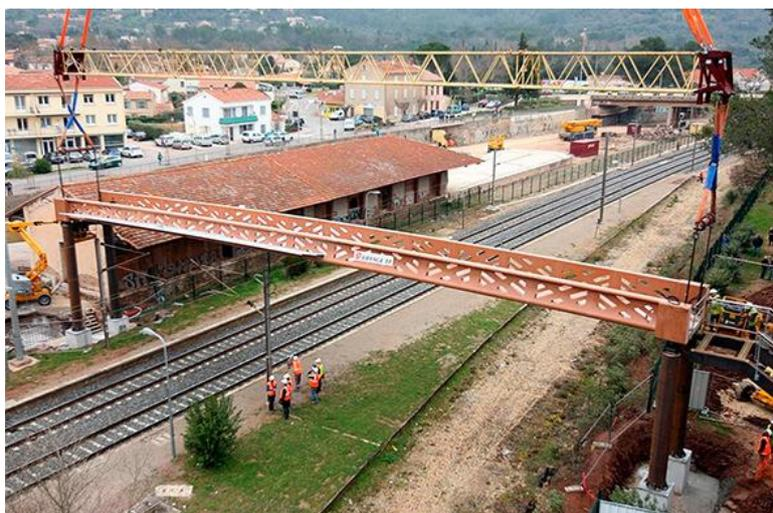
**Рисунок 7.** Пешеходный переход через железнодорожные пути в Le Cannet-des-Maures (Франция), пролет 34 м <https://lafargeholcimrus.ru/advises/article/o-primeneni-sverkhvysokoprochnogo-fibrobeta-ductal-v-rossiyskom-mostostroenii/>
