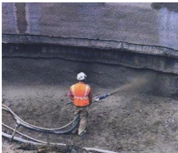
Рисунок 1. Устройство штукатурной гидроизоляции
