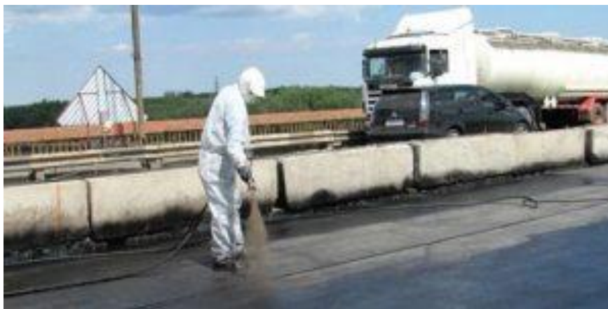
Рисунок 5. Устройство насыпной гидроизоляции (источник: https://lrgidroizolyaciya.ru/services/gidroizolyatsiya/gidroizolyatsiya-dorozhnogo-polotna/ )
