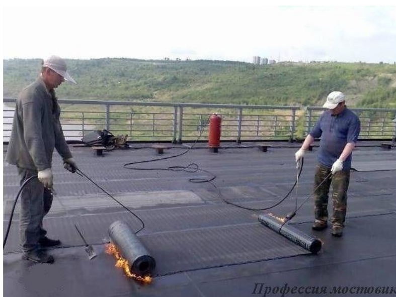
Рисунок 4. Устройство рулонной гидроизоляции
