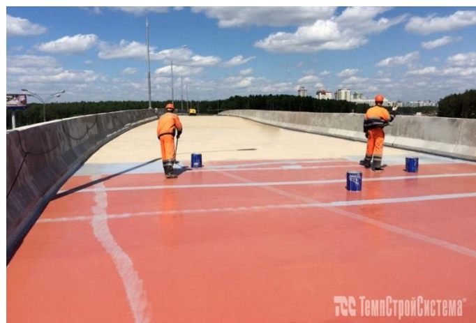
Рисунок 6. Устройство мастичной гидроизоляции (источник: https://stroy-magazin.ru/catalog/transport-built-products/waterproof-rubberflex-55/ )
