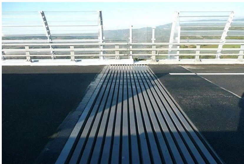
Рисунок 6. Поворотный поперечный деформационный шов (источник: https://www.maurer.eu/de/produkte/dehnfugen/dehnfugen-fuer-strassenbruecken/index.html )
