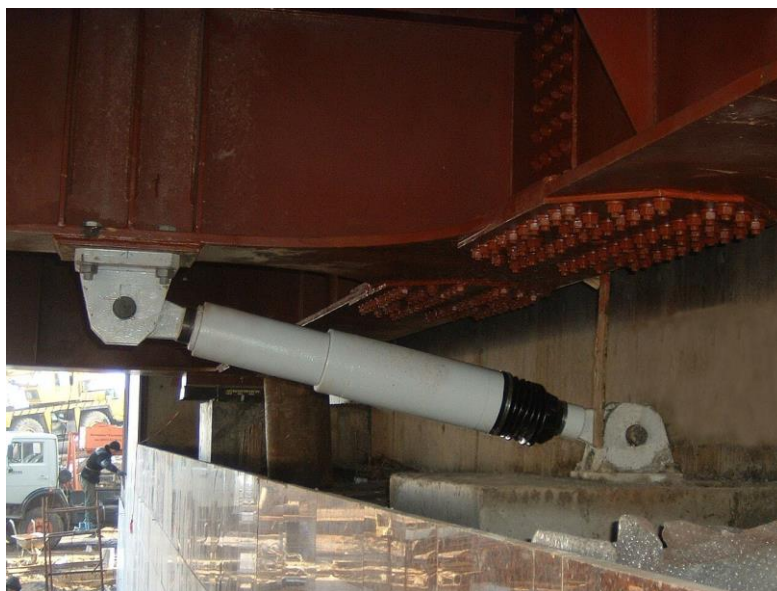
Рисунок 22. Стальной гидравлический демпфер RESTON@SA (источник: https://www.mageba-group.com/ru/ru/1026/Buildings/Seismic-devices/LASTO-HDRB/Detail.htm )
