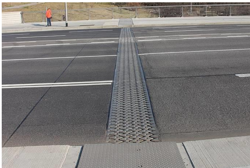
Рисунок 5. Решетчатый деформационный шов (источник:
