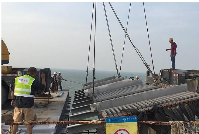
Рисунок 7. Деформационный шов скольжения (источник: https://www.maurer.eu/de/produkte/dehnfugen/dehnfugen-fuer-strassenbruecken/index.html )
