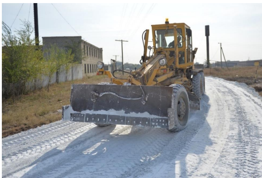
Рисунок 4. Строительство участка автомобильной дороги на территории Балаковского филиала АО «АПАТИТ» в Балаковском районе Саратовской области
