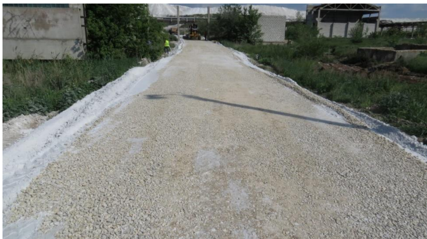
Рисунок 3. Опытный участок дороги на территории Балаковского филиала АО «АПАТИТ» в Балаковском районе Саратовской области
