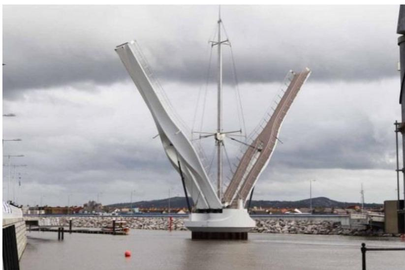
**Рисунок 23.** Разводной пешеходный «Мост Дракона» в Форид Харбор из стеклопластика и углепластика. Рил, Денбишир, Уэльс, Великобритания. 2013 г.
