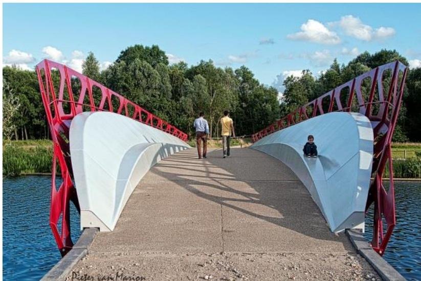
**Рисунок 22.** Пешеходный мост Симбио с пролётным строением на основе фиброармированного композита. Мидден-Делфланд, Голландия. 2016 г.
