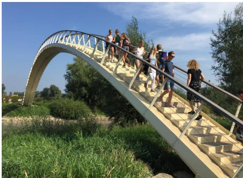
*Рисунок 17. Арочный мост из фиброармированного полиэстера. Ойпорт, Голландия. 2014 г.*
