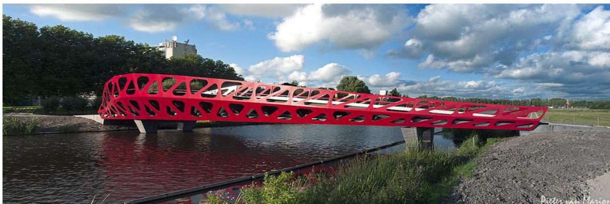
*Рисунок 21. Пешеходный мост Симбио с пролётным строением на основе фиброармированного композита. Мидден-Делфланд, Голландия. 2016 г.*
