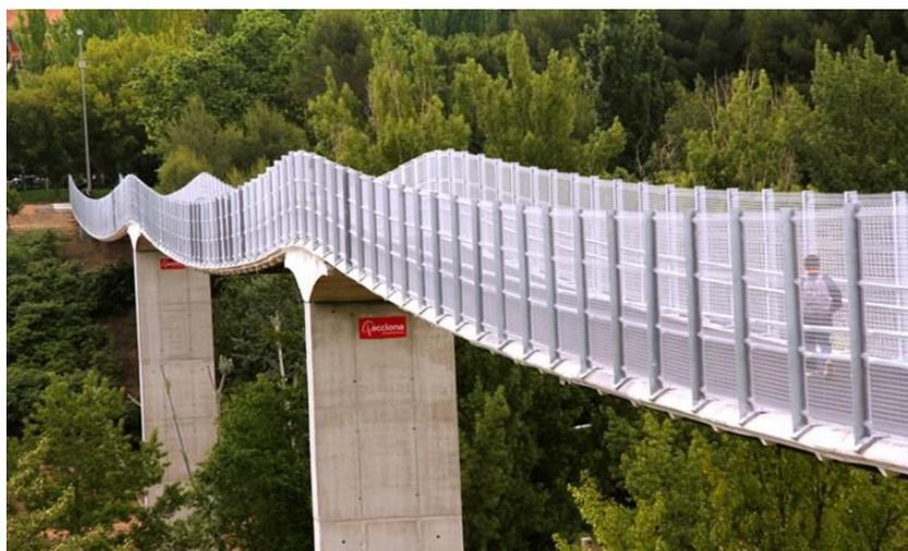
*Рисунок 18. Пешеходный мост через реку Хукар на нитях из углепластика. Куэнка, Испания*
