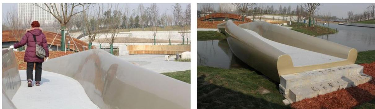
**Рисунок 27.** Пешеходный мостик из стекловолокна и акрилонитрил-стирол-акрилата, напечатанный на 3D-принтере. Шанхай, Китай
