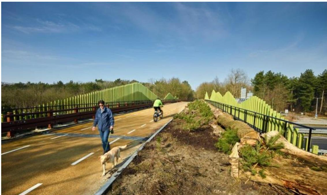
*Рисунок 5. Виадук Зумленд. Экологический переход через автомагистраль A58 с фасадными конструкциями из органопластика (биоразлагаемый композит из эпоксидной смолы, армированной льняным волокном). Голландия. 2017 г.*
