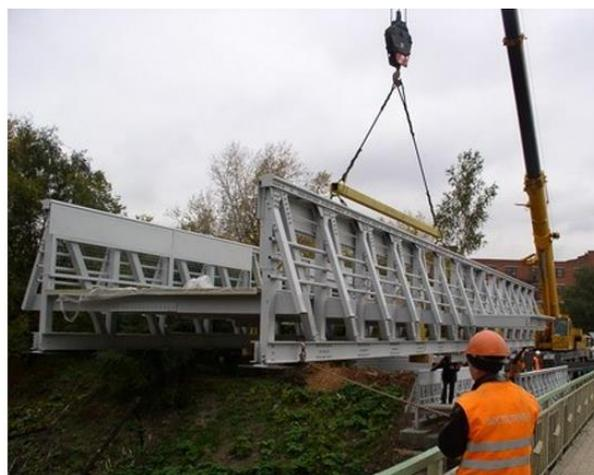
**Рисунок 8.** Первый в России мост с цельнокомпозитным пролётным строением из пултрузионного стеклопластика. Железнодорожная Станция «Чертаново», Москва, Россия. 2004 г.
