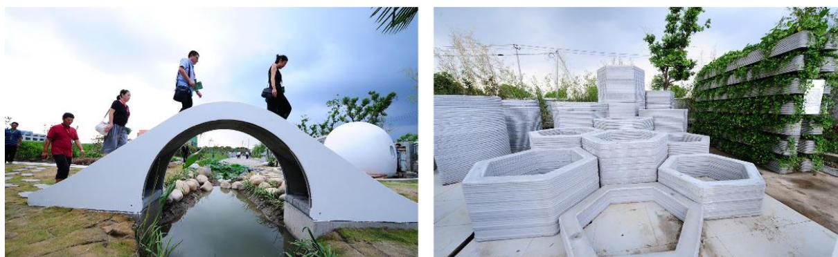
*Рисунок 7. Малые архитектурные формы в парке: пешеходный мостик и клумбы из стеклопластика, изготовленные с помощью трёхмерной печати. Шанхай, Китай. 2018 г.*
