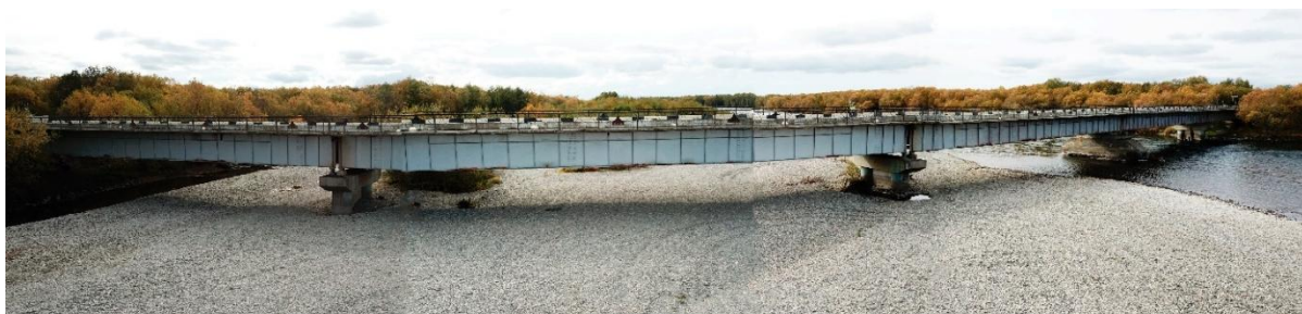
Рисунок 22. Общий вид фасада моста через реку Быстрая до ремонтных работ (фото автора)
