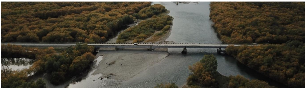
Рисунок 21. Вид сверху на мост через реку Быстрая до ремонтных работ (фото автора)
