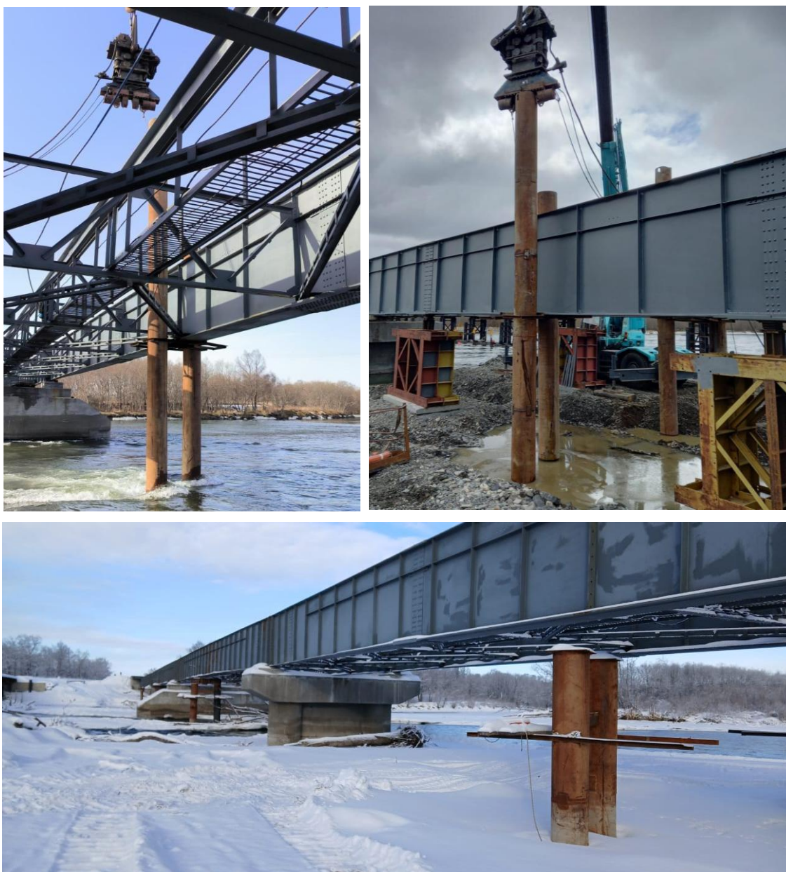
Рисунок 25. Сооружение временных опор под пролетными строениями моста через реку Быстрая (фото автора)
