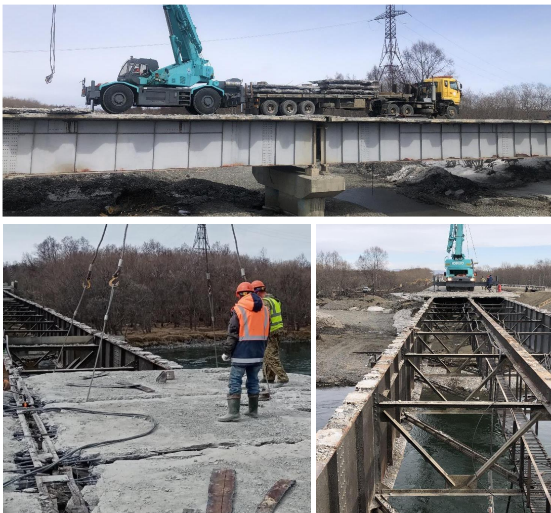
Рисунок 24. Демонтаж существующих железобетонных плит проезжей части моста через реку Быстрая (фото автора)
