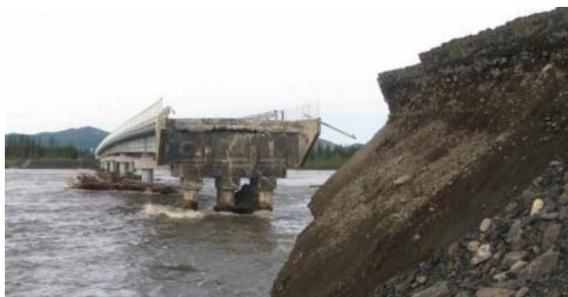
Рисунок 8. Размыв насыпи подхода к мосту в Якутии [16]
