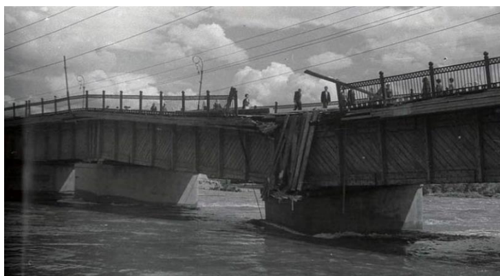
Рисунок 7. Мост в г. Чите после наводнения в 1971 году [16]
