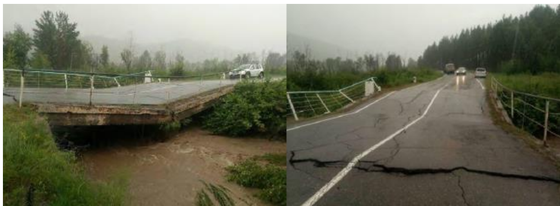
Рисунок 4. Мост через реку Сыпчегур в Забайкалье [14]
