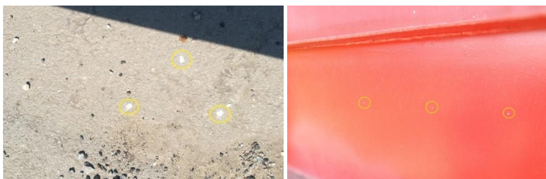
а) б) Рисунок 5. Точки в области измерения элемента пролетного строения: а) асфальтобетонное покрытие; б) главные балки
