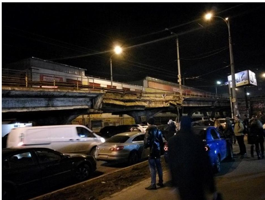
Рисунок 5. Обрушение путепровода в Киеве, Украина (источник: https://korrespondent.net )
