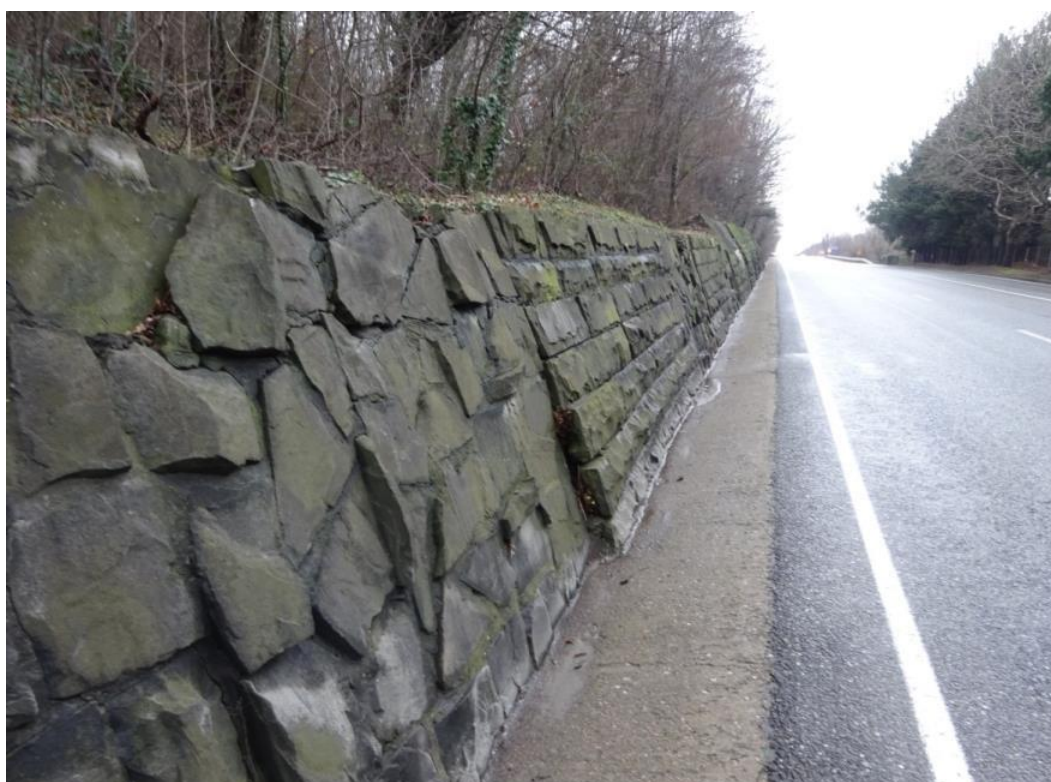
Рисунок 2. Подпорная стена до выполнения работ по устройству облицовочной панели (фото автора)
