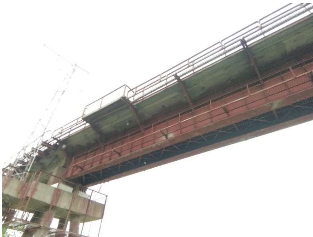
Рисунок 3. Сталежелезобетонное пролетное строение (фото автора)
