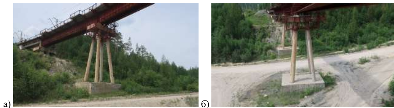
Рисунок 2. Общий вид опор: а — Оп № 2; б — Оп № 3 (фото автора)
