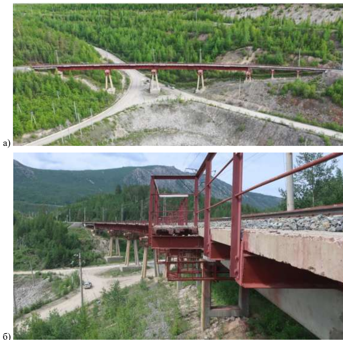
Рисунок 1. Общий вид виадука: а — правый фасад; б — вид с опоры № 8 (фото автора)
