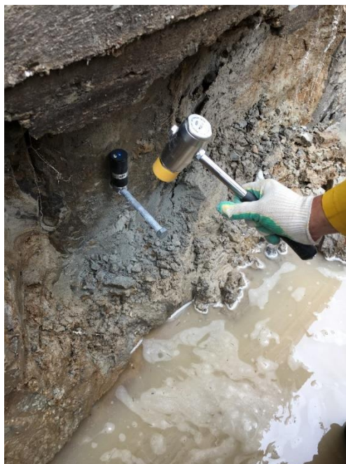
Рисунок 2. Определение длины погруженных в грунт свай методом акустической волны, возбуждаемой в свае с помощью удара (фотография выполнена авторами)
