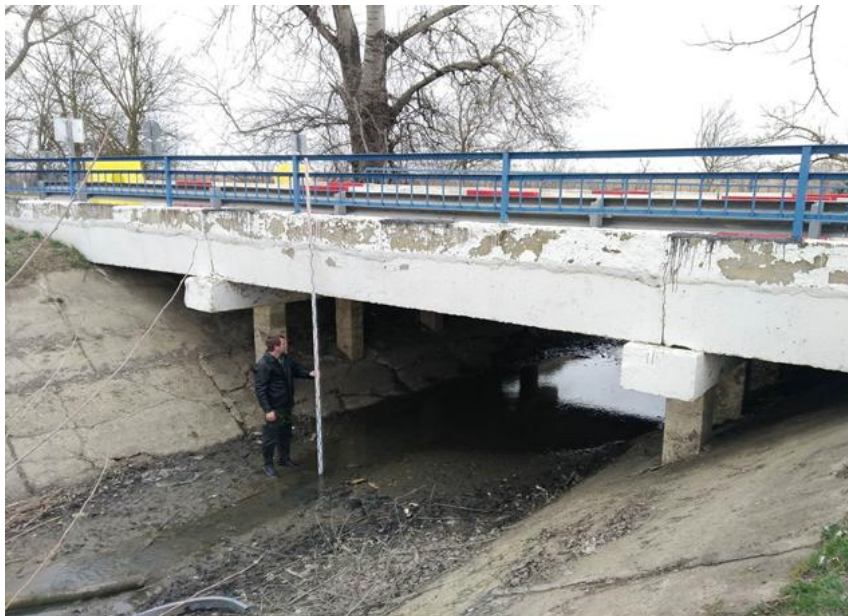
Рисунок 2. Участок перехода автодороги через мост (фото автора)
