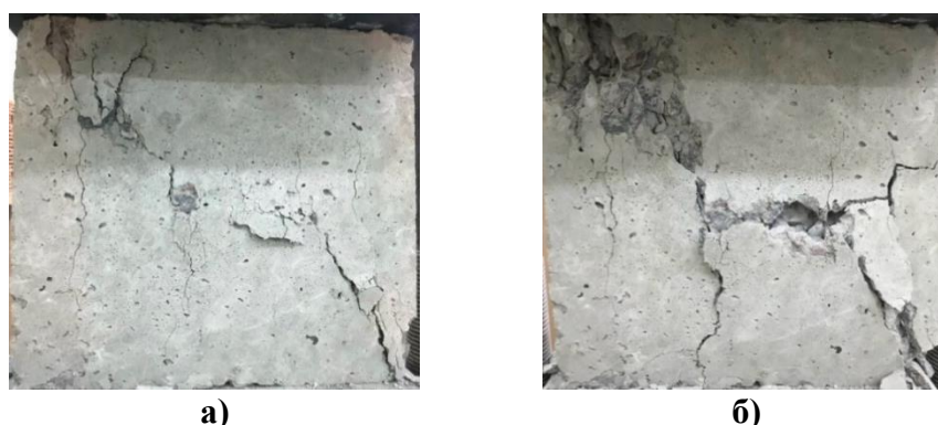
а) б) Рисунок 5. Картины разрушения армированных моделях стен МС-2 при одноосном нагружения: (а) трещинообразования; (б) разрушения
