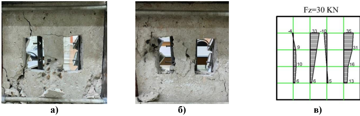
Рисунок 12. Картины трещин в моделях МС-5 от разрушающей нагрузки при одноосного (а), двухосного (б) сжатия и эпюры боковых горизонтальных перемещений (в)
