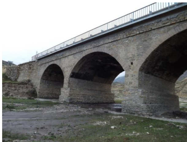
Рисунок 2. Арочный каменный мост в окрестности с. Батлаич (фото авторов)
