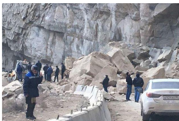
Рисунок 3. Разрушение автодороги обвалом вблизи горы Ахульго, р. Дагестан (фото авторов)
