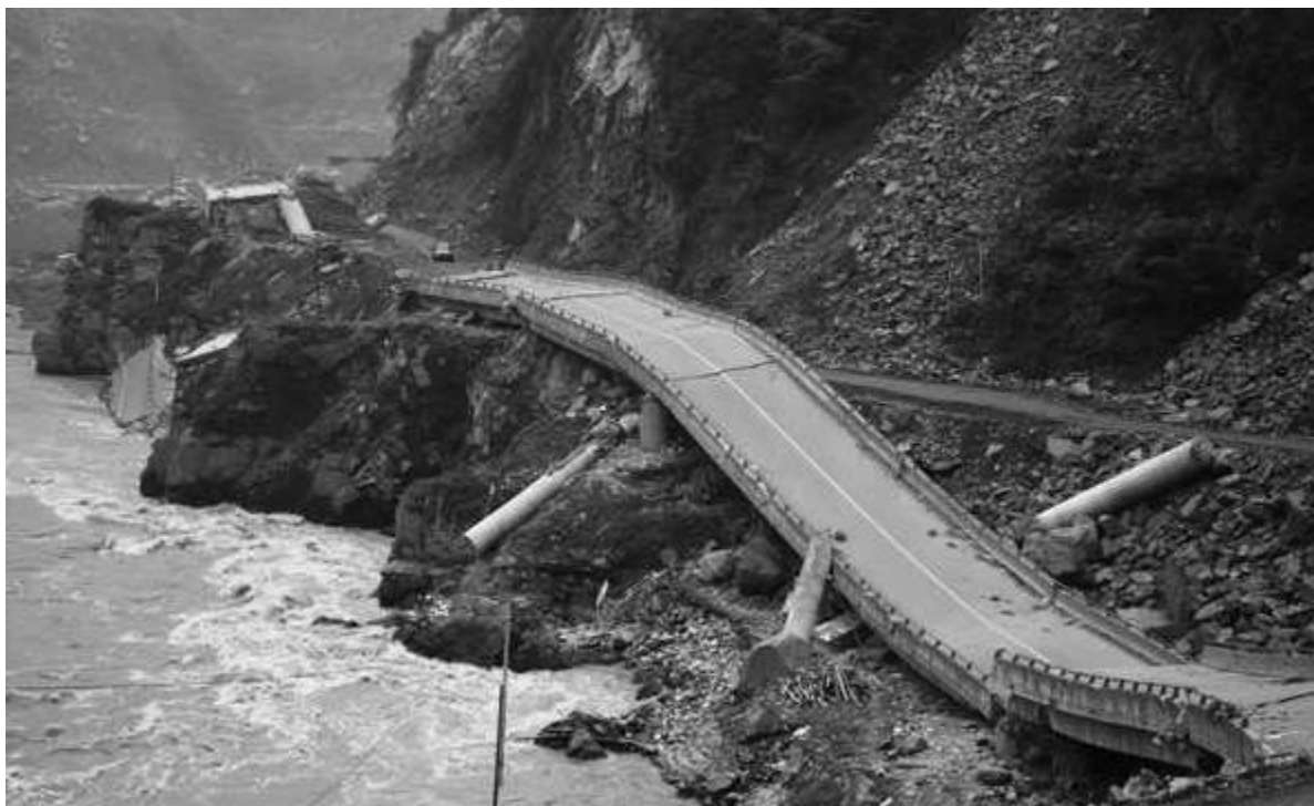
Рисунок 3. Прогрессирующее разрушение моста вследствие землетрясения [35]
