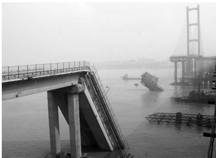
Рисунок 1. Прогрессирующее разрушение моста в Китае [34]
