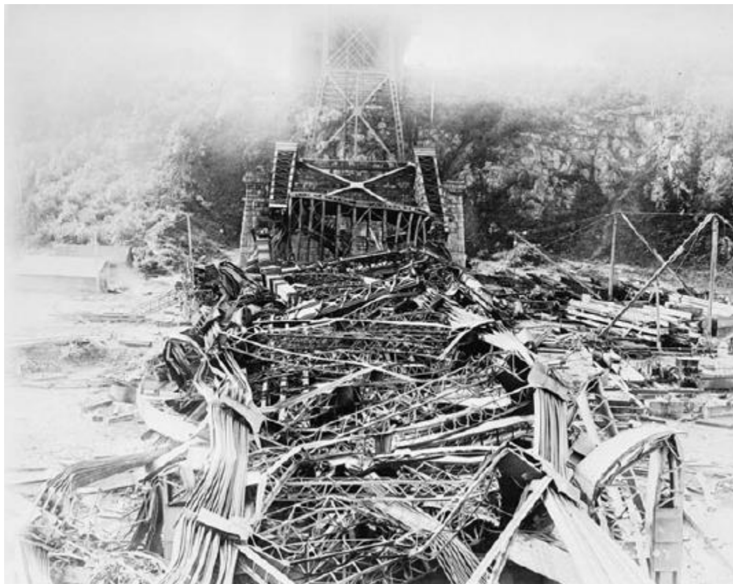
Рисунок 4. Разрушение Квебекского моста [35]
