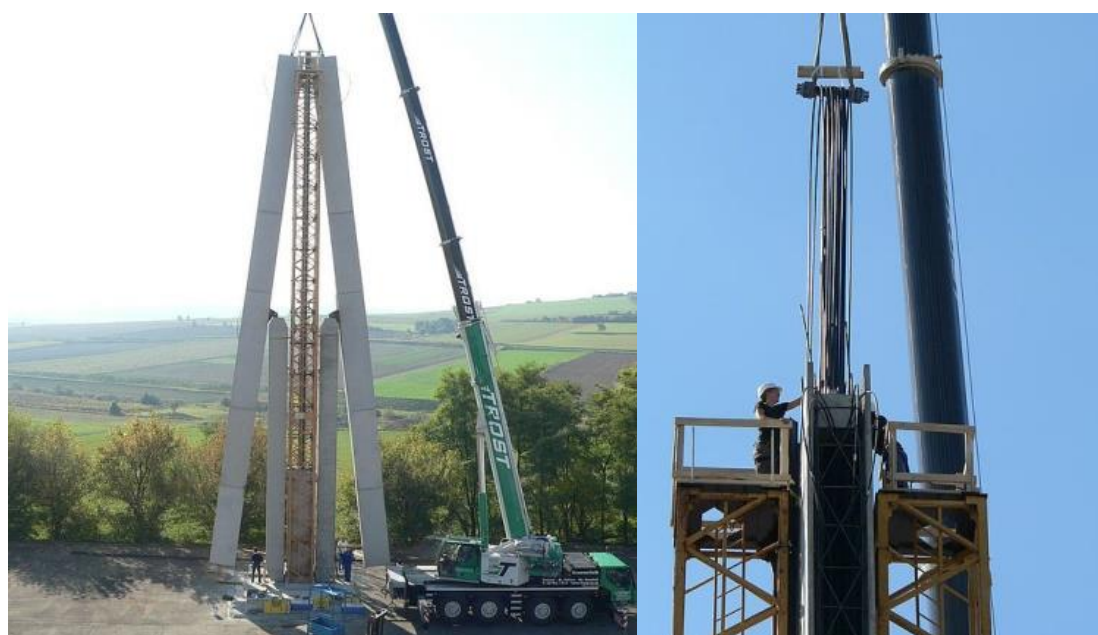
Рисунок 14. Подготовительные работы перед разворотом конструкции на р. Ланбах, Австрия
