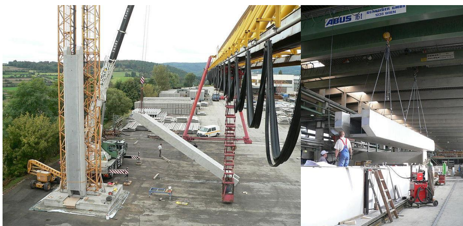
Рисунок 9. Монтаж распорки через реку Ланбах, Австрия
