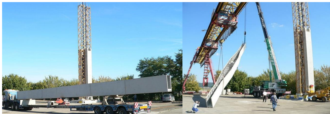
Рисунок 12. Монтаж балок башенным краном при строительстве на р. Ланбах, Австрия
