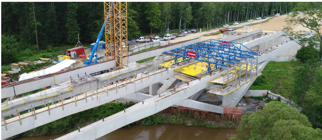
Рисунок 18. Бетонирование проезжей части на р. Ланбах, Австрия [12]
