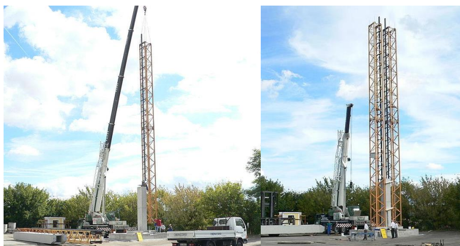
Рисунок 6. Монтаж секций вспомогательной опоры моста через реку Ланбах, Австрия
