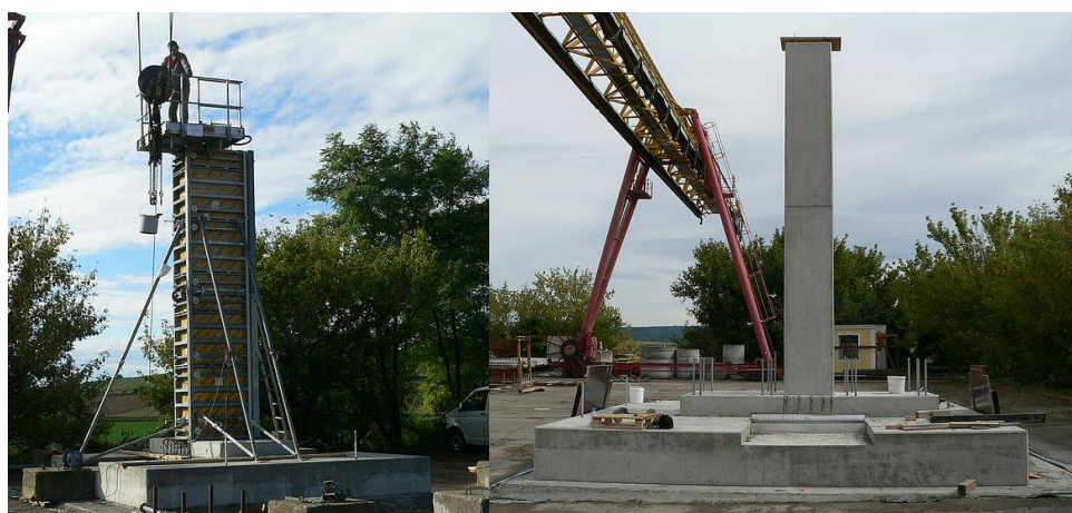
Рисунок 5. Первый этап строительства моста через реку Ланбах, Австрия
