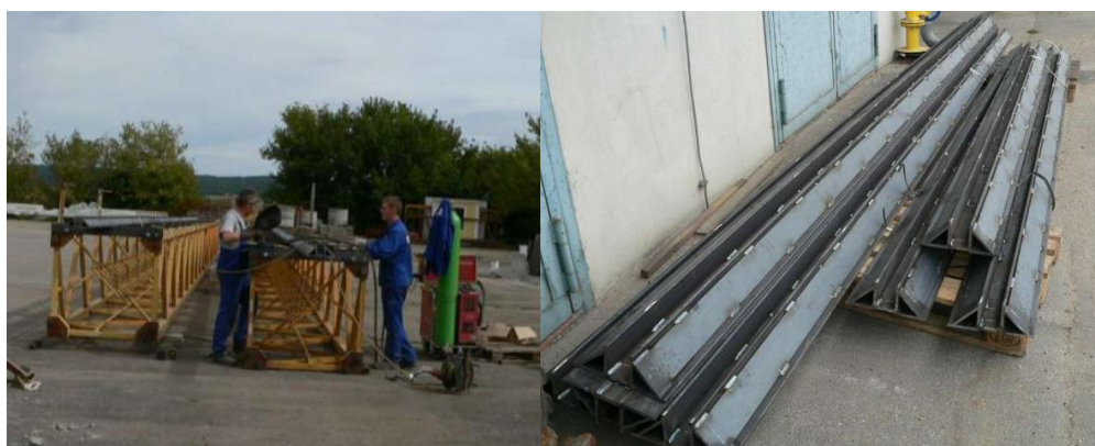
Рисунок 7. Направляющие для монострендов
