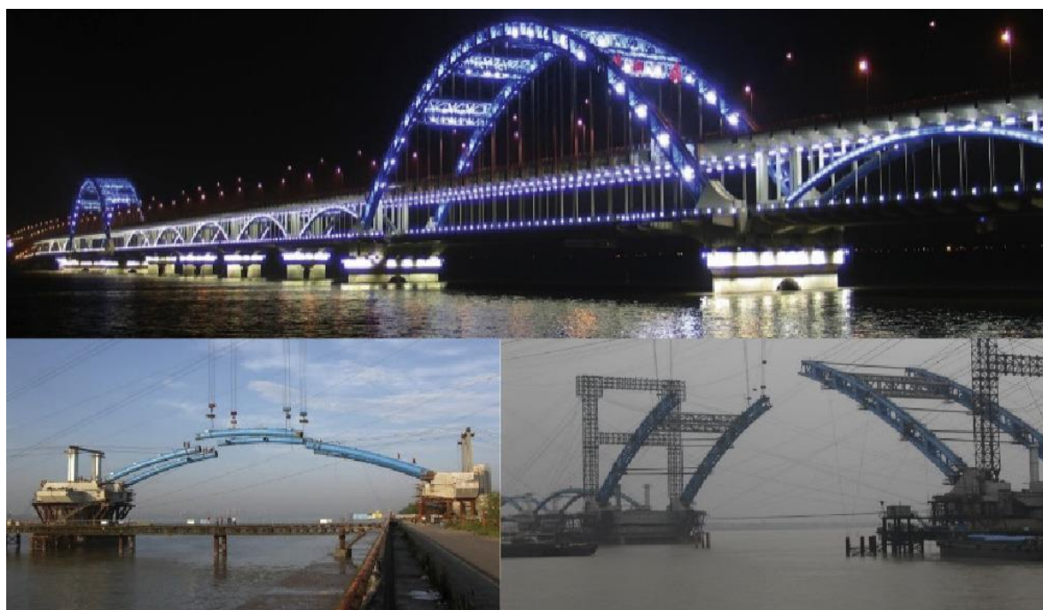
Рисунок 5. Монтаж моста Фусин в г. Ханчжоу с использованием системы временных вант [1]
