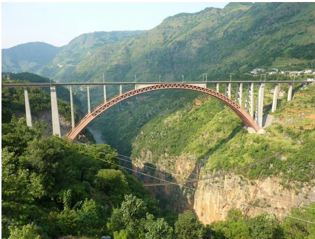
Рисунок 6. Железнодорожный мост через р. Бейпан на железнодорожном перегоне Гуйчжоу — Шуйбай (источник:
