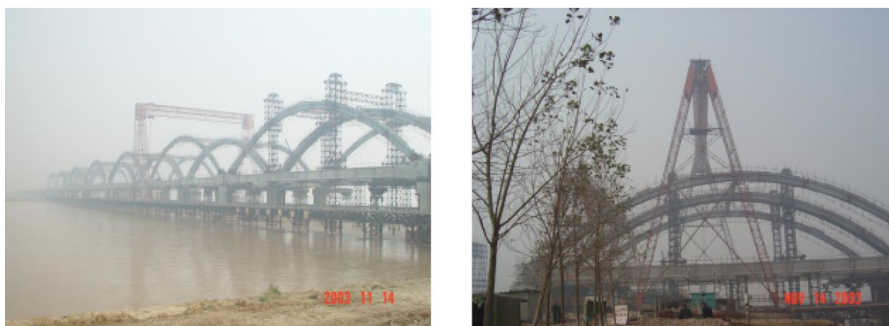
Рисунок 9. Строительство Второго моста через реку Хуанхэ в Чжэнчжоу [8]
