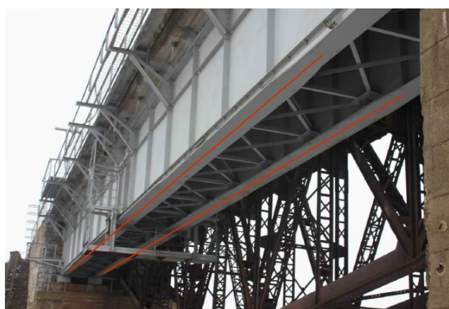
Рисунок 1. Зоны расположения датчиков на нижнем поясе балок моста (фото авторов)
