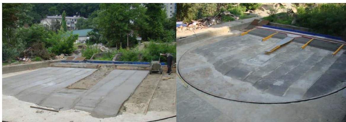
Рисунок 10. Строительство модели берегозащитных сооружений земляного полотна в районе ж.д. станции Адлер в волновом бассейне в масштабе 1:35 (фото автора)
