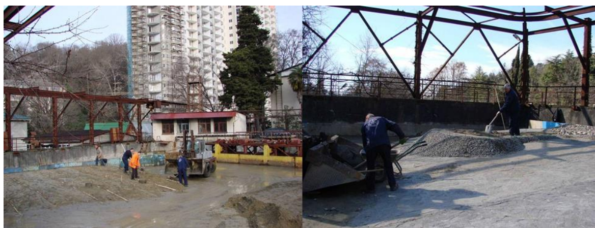
Рисунок 7. Строительство модели технологической площадки моста в волновом бассейне в масштабе 1:52 (фото автора)
