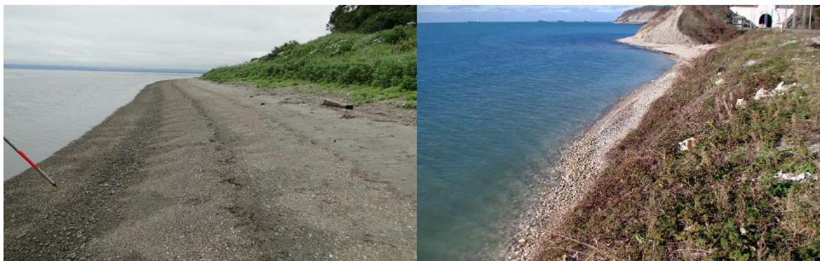
Рисунок 4. Натурные наблюдения и обследования береговой зоны вблизи земляного полотна железных дорог (разработано автором)
