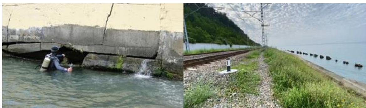
Рисунок 1. Обследование основания волноотбойной стены и земляного полотна. Участок Туапсе-Адлер СКЖД (разработано автором)
