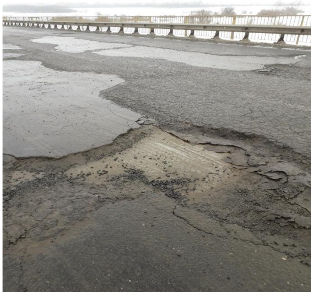
Рисунок 1. Накопление повреждений ездового полотна (б) мостового сооружения с примененной (а) рулонной наплавляемой гидроизоляцией (фото ФКУ УПРДОР «Нижне-Волжское»)
