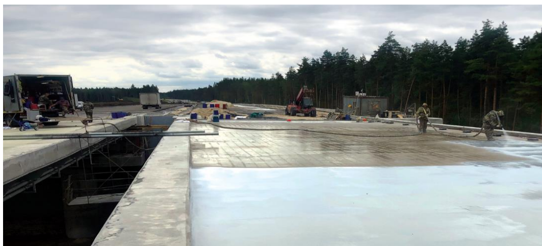
Рисунок 3. Оборудование и работы для устройства напыляемой гидроизоляции (фото авторов)
