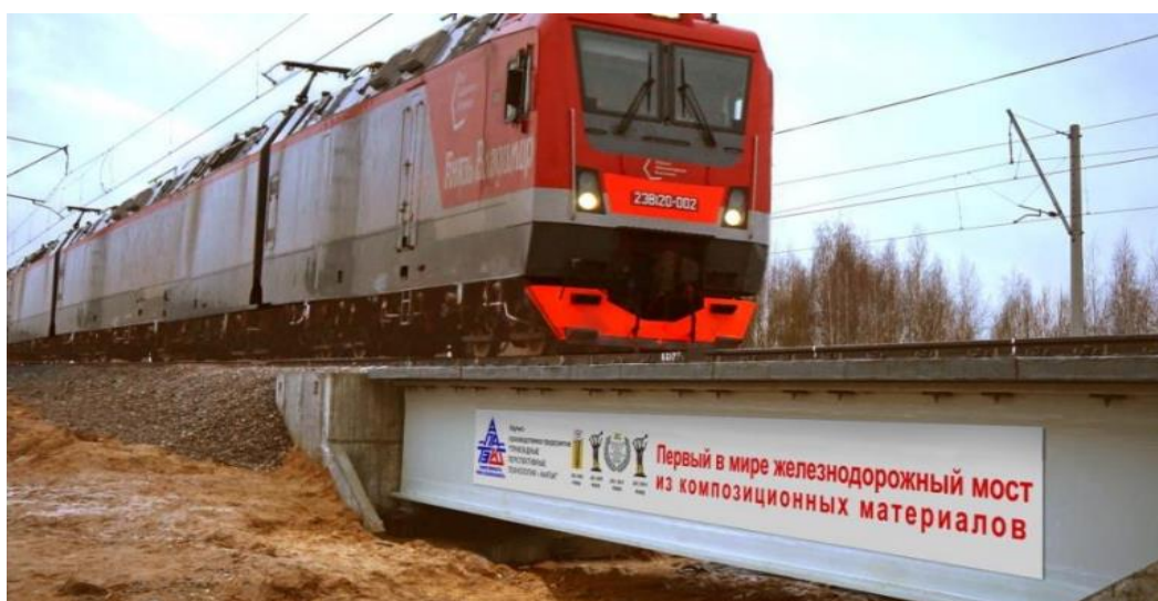
Рисунок 12. Первый в мире железнодорожный мост из полимерных композитных материалов 9 (источник: https://soyuzmash.ru/docs/kom/122080/Ushakov.pdf )
