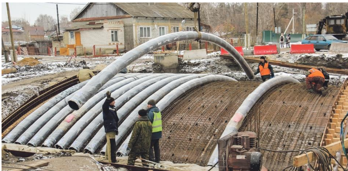
Рисунок 10. Укладка углепластиковых труб при строительстве автодорожного арочного моста через ручей Соловей (источник: https://strana-rosatom.ru/2017/08/07/doroga-zavtrashnego-dnya/ , изображение Сергея Юрьева)
