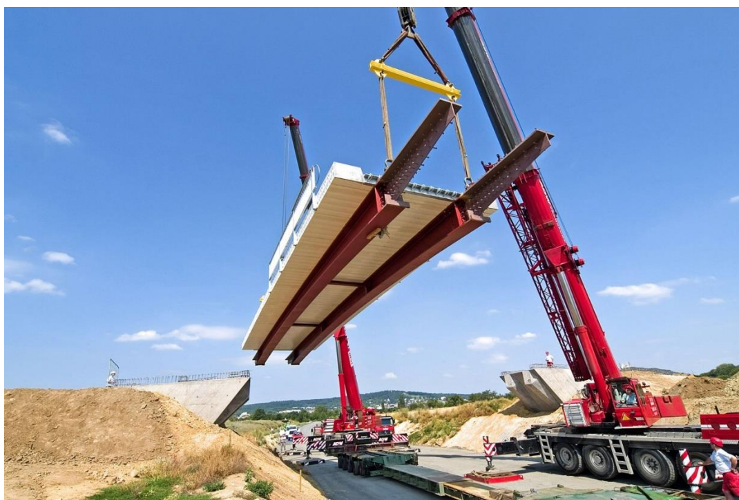
Рисунок 6. Установка пролетного строения Фридбергского моста (источник: https://www.itke.uni-stuttgart.de/research/built-projects/road-bridge-with-frp-decks/ , изображение Яна Книпперса)
