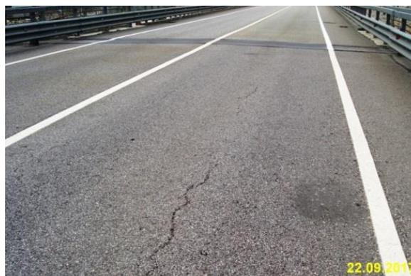
**Рисунок 1.** Трещины в асфальтобетонном
