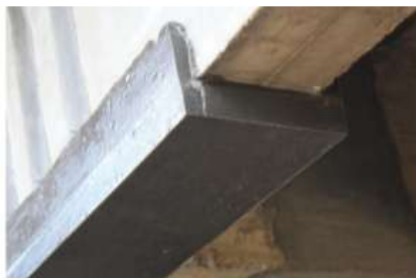
Рисунок 2. Усиление растянутой зоны разрезной тавровой балки полиуретан-цементным композитом (источник [4])
