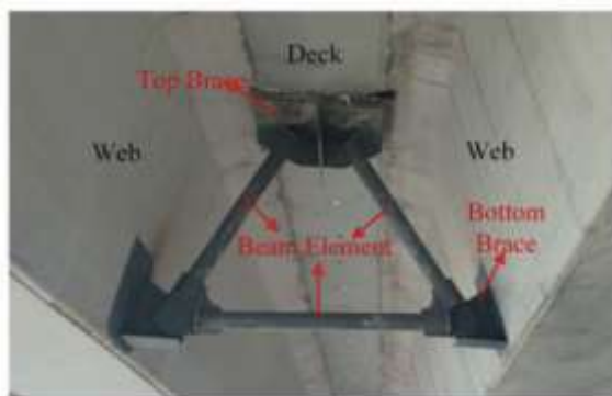
Рисунок 18. Стальные треугольные связи для увеличения поперечной жесткости пролетного строения (источник [24])
