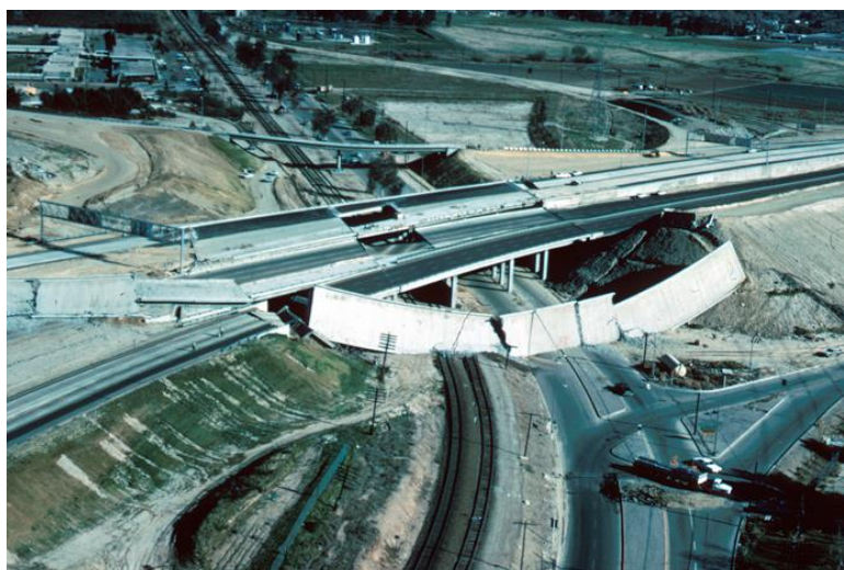
Рисунок 1. Разрушенная эстакада, развязка между штатами, февраль 1971 года (источник: https://en.wikipedia.org/wiki/1971_San_Fernando_earthquake#/media/File:1971_San_Fernando_highway_overpass_collapse.jpg , автор фото: Reuben Kachadoorian)
