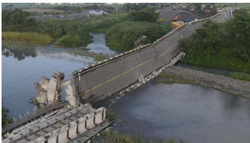
Рисунок 13. Общий вид моста Gaoliao Bridge в Тайване (источник: Кадр из видеоролика: https://edition.cnn.com/2022/09/18/asia/taiwan-earthquake-tsunami-warnings-intl/index.html?utm_source=twCNN&utm_content=2022-09-20T01%3A01%3A03&utm_medium=social&utm_term=video , CNN)
