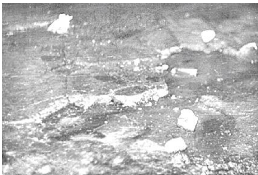
Рисунок 2. Разрушение полов под воздействием водных растворов глицерина (фото автора)
