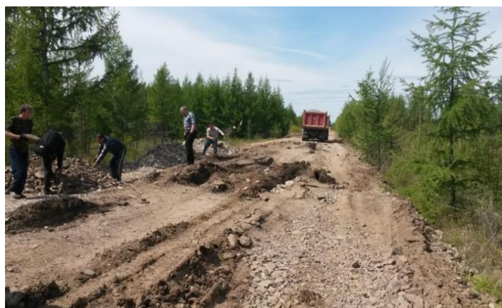
Рисунок 3. Экспериментальный участок автодороги по состоянию на июль 2015 г. (фото авторов)
