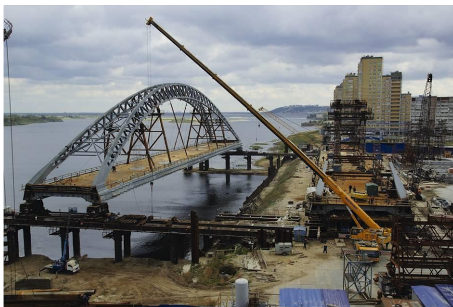
Рисунок 10. Поперечная передвижка пролетного строения (разработано автором)
