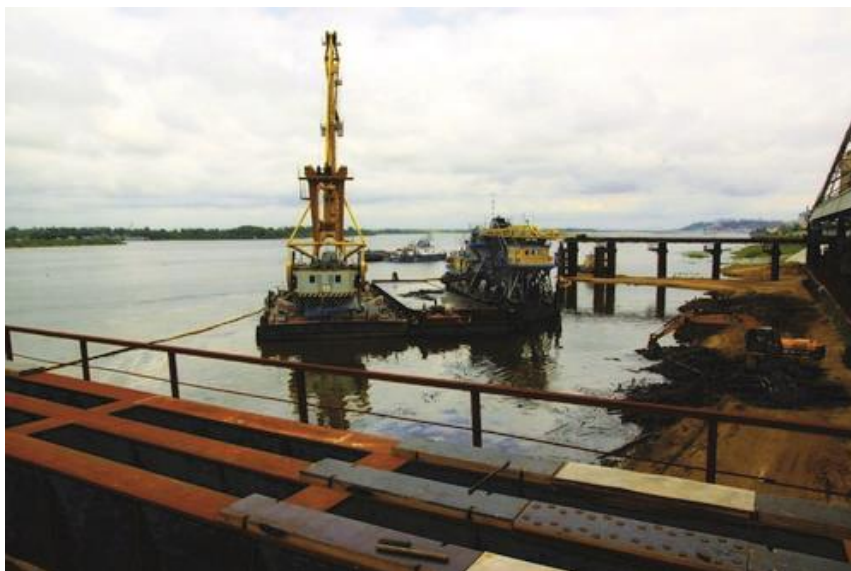
Рисунок 4. Дноуглубление ковша (разработано автором)
