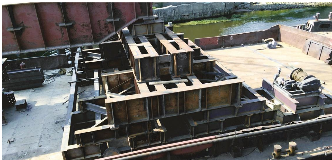
Рисунок 14. Распределительная обстройка плавопоры (разработано автором)
