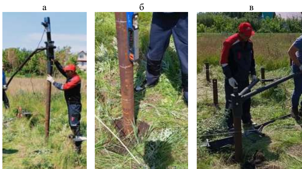
Рисунок 5. Этапы проведения исследований: а — погружение сваи; б — разметка для контроля глубины погружения; в — измерение крутящего момента (фото автора)
