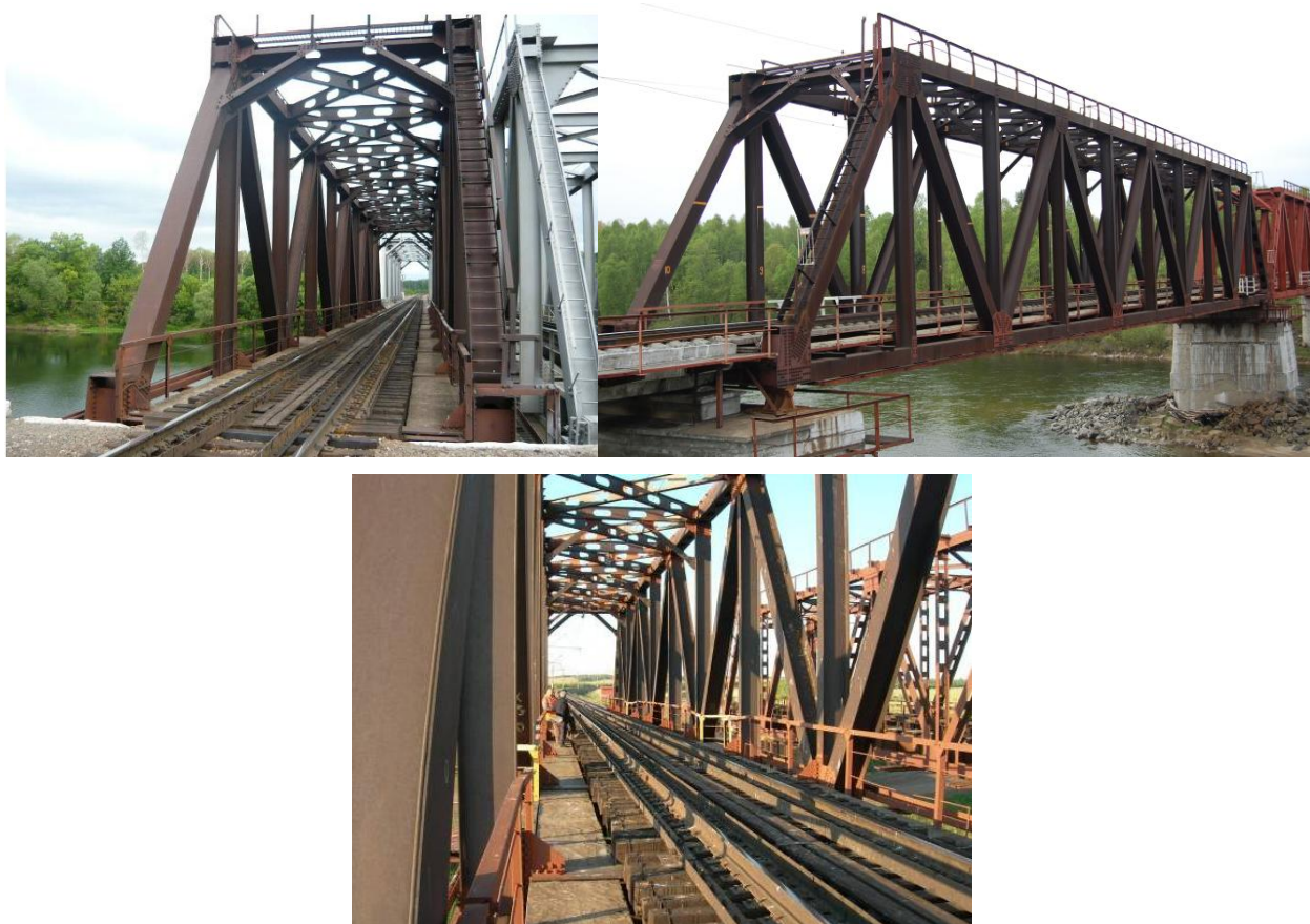
Рисунок 1. Элементы пролётных строений мостовых сооружений, выполненных из атмосферостойкой стали, спустя 21 год эксплуатации без применения окрасочного слоя [10]
