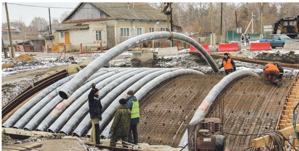
Рисунок 13. Монтаж арочных трубобетонных элементов грунтозасыпного моста в Ульяновской области [19]
