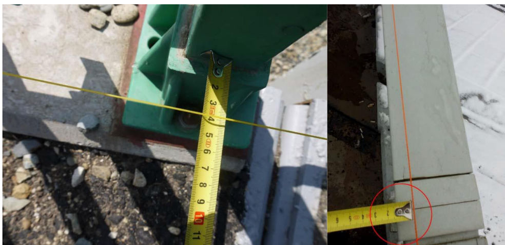
Рисунок 10. Отклонение оси перильного ограждения от проектного положения [12]
