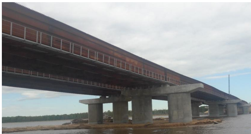
Рисунок 3. Мост через р. Шоша на ПК 1260+38 [10]
