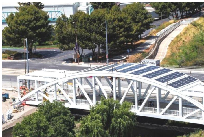
Рисунок 19. Солнечные панели на мосту Levis Stadium [23]
