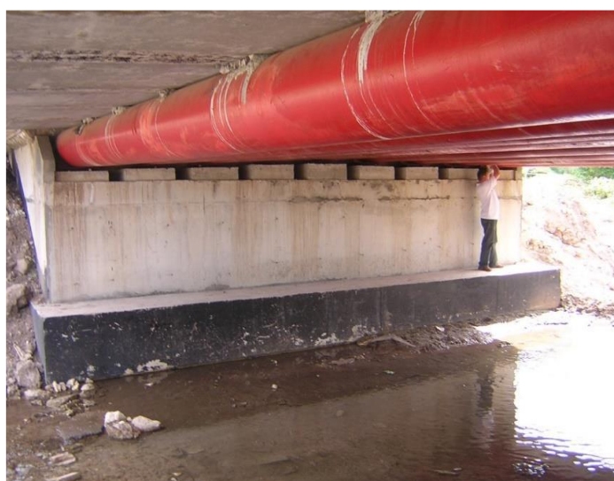
Рисунок 15. Трубобетонное пролетное строение с применением старогодных труб (фото авторов)
