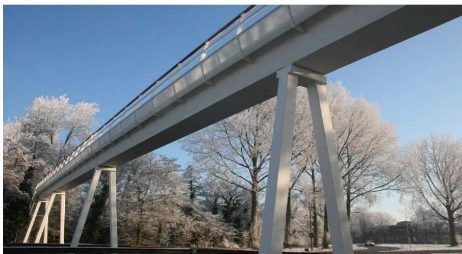
Рисунок 7. Пролётное строение моста выполнено из полимерного композиционного материала [10]
