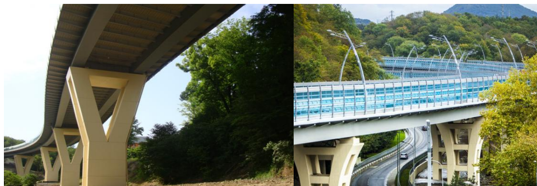
Рисунок 6. Состояние системы антикоррозионной защиты моста через реку Мацеста в г. Сочи по истечении 20 лет эксплуатации (фото авторов)
