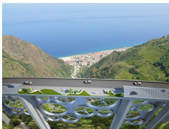
Рисунок 17. Расположение ветрогенераторов на виадуке [22]
