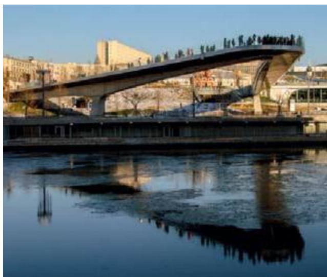
Рисунок 12. Монолитное постнатяжённое пролетное строение «Парящего моста» в парке «Зарядье» [16]
