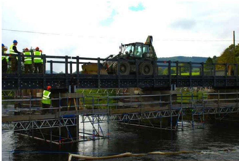
Рисунок 11. Пешеходный пластиковый мост из вторичных полимерных материалов выдерживает грузовик [14]
