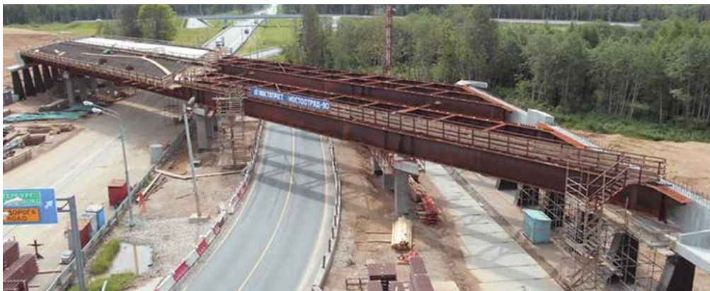
Рисунок 2. Путепровод на ПК 2565+44,29 на автомобильной дороге первой категории М-11 «Нева» [10]
