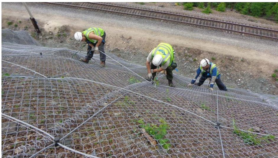
Рисунок 5. Установка мелкоячеистых сеток 5 (автор: Вера Григорьева)
