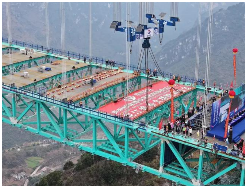
Рисунок 6. Монтаж конструкций с помощью канатной системы 3 (Автор: Xinhua)
