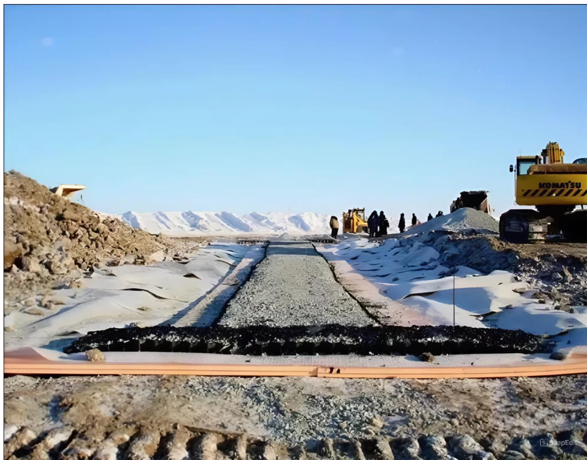
Рисунок 2. Уложенные плиты «ПЕНОПЛЭКС» под будущей железной дорогой (источник: https://timotv.livejournal.com/162194.html?noscroll . Автор: Ямалтранстрой)
