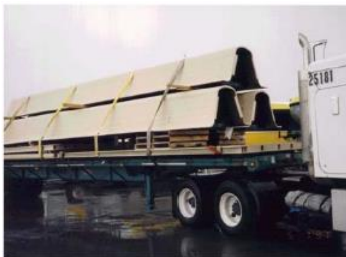
Рисунок 3. Литые U-образные балки (перевернутые) для моста INEEL [4]
