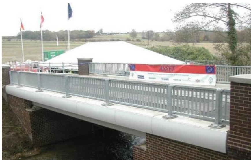
Рисунок 5. West Mill Bridge, Oxfordshire, Великобритания, 2002 [7]
