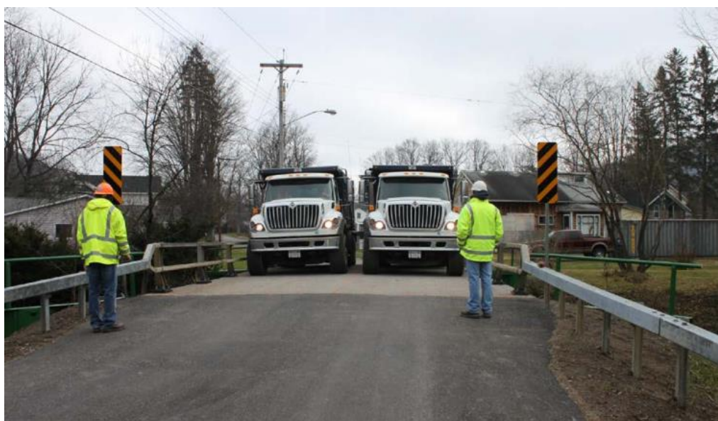
Рисунок 2. Испытания для определения грузоподъемности моста с полимерно-композитным настилом (источник: https://www.fhwa.dot.gov/hfl/partnerships/composite_bridge/hif13029/chap04.cfm#fig32 )
