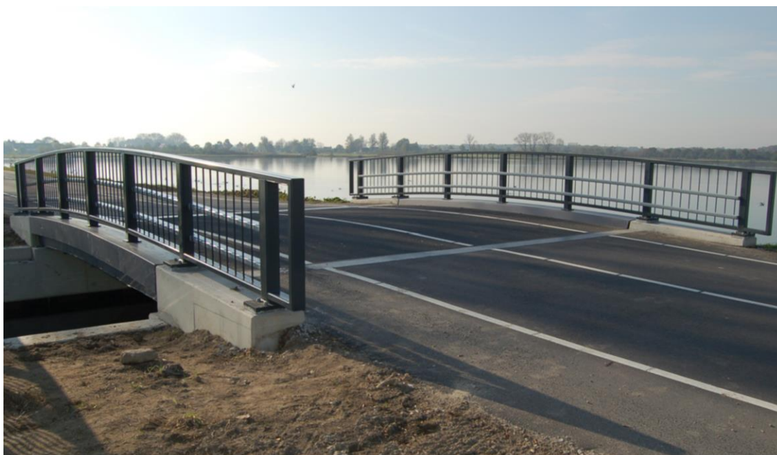
Рисунок 4. Автодорожный полимерный композитный мост Маарссензевег в Утрехте [6]
