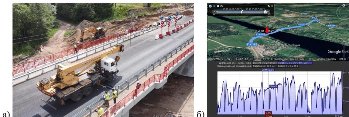
**Рисунок 6.** Проход одиночной нагрузки (а) и инструмент мониторинга скорости движения нагрузки (б) (фотография и снимок экрана сделаны автором)
