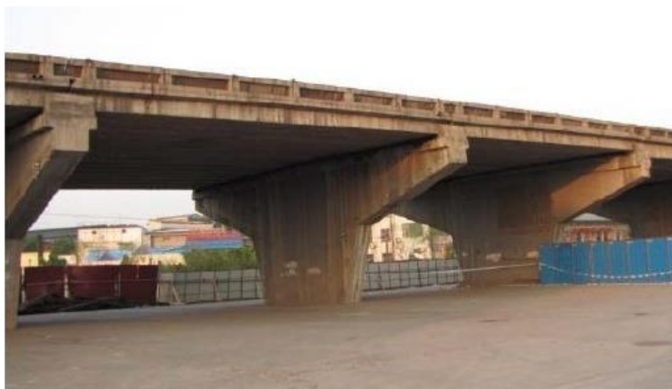
Рисунок 1. Виадук Хунци до разрушения (снимок по материалам Kaiming Bi, Hong Hao «Progressive collapse analysis of Hongqi Viaduct: a multi-span simply-supported bridge» [1])
