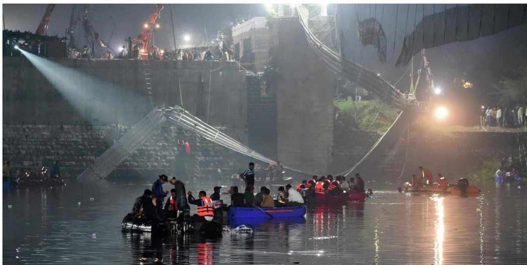
Рисунок 3. Обрушение моста в Индии (автор фотографии Sam Panthak 2 )
