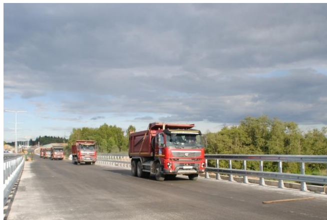
Рисунок 4. Динамические испытания процесса нагруженности ПС моста через реку Истра (проезд 6 груженных автомобилей)
