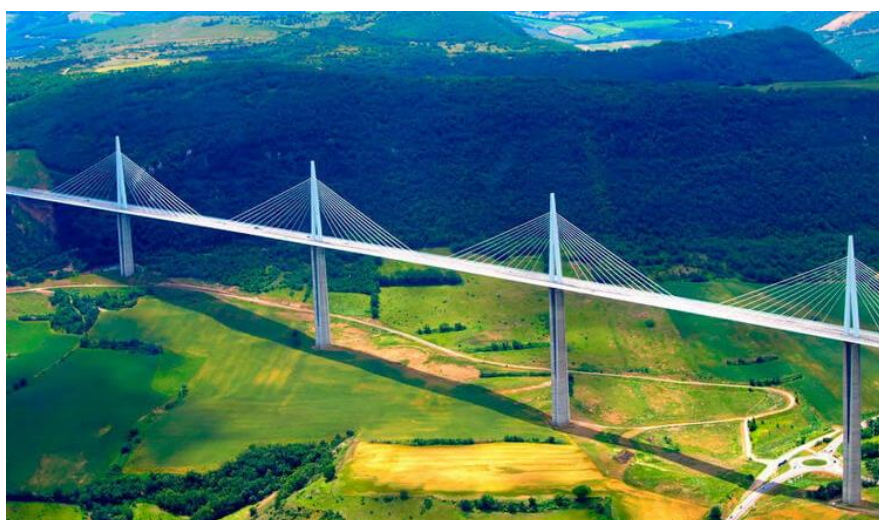
Рисунок 4. Виадук Мийо (Франция), 2004 год. Вантовый восьмипролётный мост длиной 2460 м (источник https://pressa.tv/web-puteshestviya/119734-viaduk-miyo-samyy-vysokiy-most-v-mire.html )
