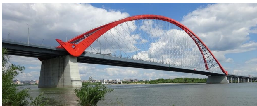
Рисунок 3. Бугринский мост через р. Обь в Новосибирске. «Сетчатая арка», пролётом 380 м, 2014 год (источник https://avatars.mds.yandex.net/get-pdb/367895/9738760a-3ce7-4d02-9c75-0e827a188df8/s1200 )
