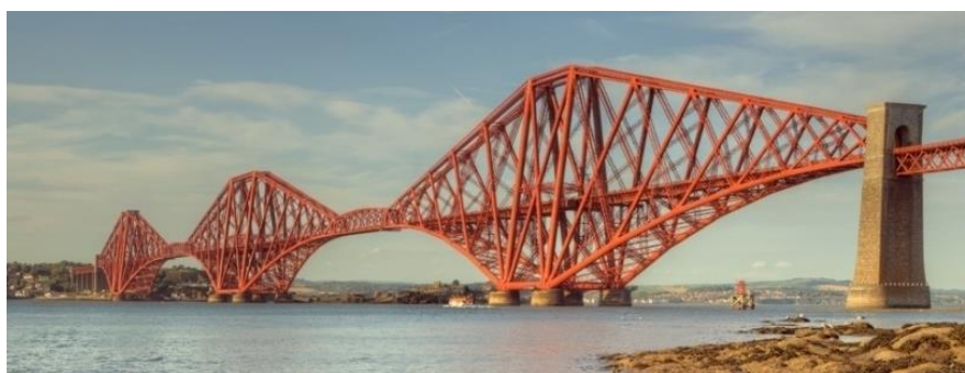
Рисунок 2. Железнодорожный мост через реку Форт (Шотландия). 1889 год (источник https://ucrazy.ru/other/1439454121-zheleznodorozhnyy-most-fort-bridzh.html )
