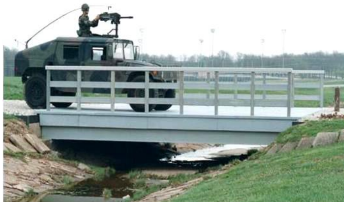
Рисунок 13. Автомобильный мост в в/ч Форт Леонард Вуд», штат Миссури, построенный в 1998 году с максимальной грузоподъемностью 12,5 тонн
