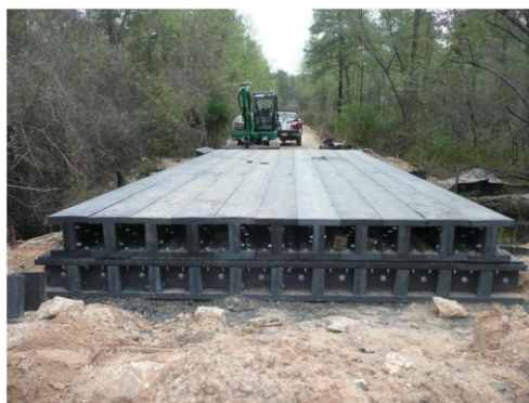
Рисунок 17. Балки, установленные на мосту Т85-18 по длине
