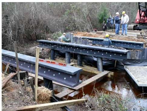
Рисунок 16. Двутавровые балки пролетного строения установлены и закреплены на трех рядах свай. Мост T85-18
