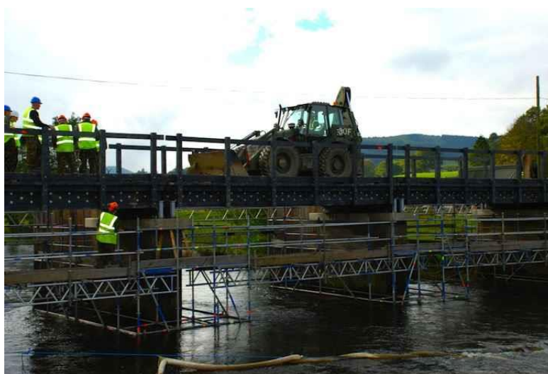
Рисунок 19. Пешеходный пластиковый мост через реку Твид выдерживает грузовик
