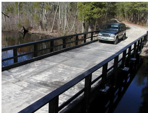
Рисунок 14. Автомобильный мост в государственном лесу Уортон, штат Нью-Джерси, построенный в 2002 году из двутавровых балок, Максимальная грузоподъемность 36 тонн
