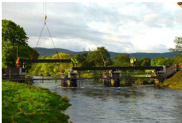
Рисунок 20. Монтаж элементов пролетного строения пешеходного моста через реку Твид
