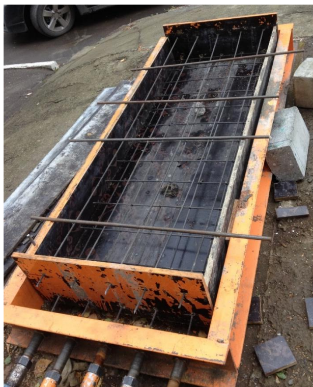
Рисунок 2. Опорная рама (фото авторов) Figure 2. Support frame (photo of the authors)
