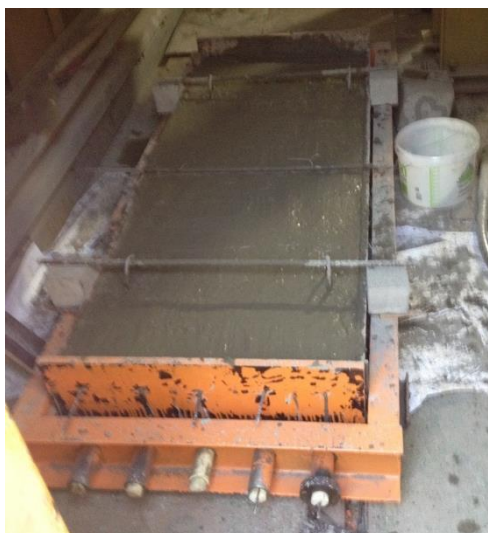
Рисунок 11. Установка после заливки бетона в опалубку (фото авторов) Figure 11. Installation after pouring of concrete in the formwork (photo of authors)
