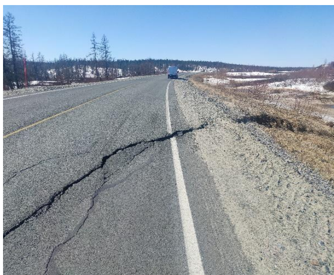
Рисунок 2. Деформированный участок автомобильной дороги (автор: Синицкий А.И. Из архива «Государственное автономное учреждение Ямало-Ненецкого автономного округа «Научный центр изучения Арктики»)
