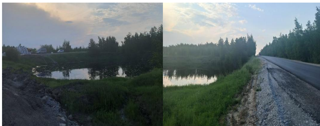
Рисунок 1. Водоем вдоль откосных частей земляного полотна (источник: https://www.dissercat.com/content/vliyanie-obvodneniya-na-temperaturnyi-rezhim-merzlogo-osnovaniya-nasypnykh-sooruzhenii . Авторы: Сыромятников И.И., Литовко А.В., Жирков А.Ф., Кириллин А.Р.)
