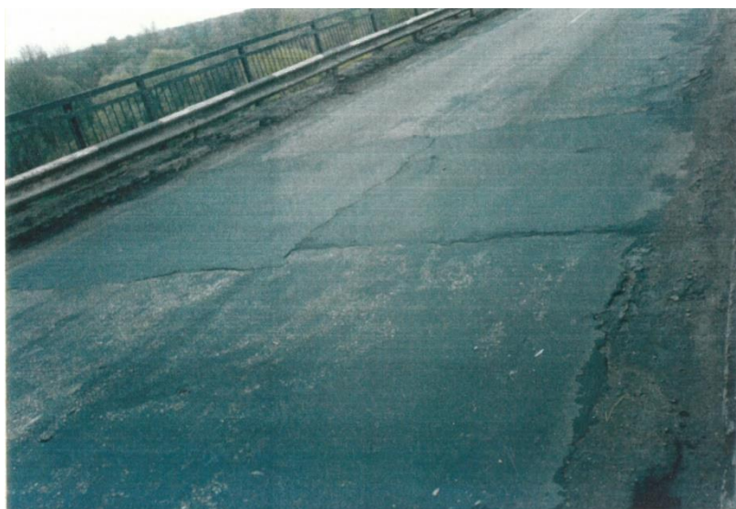
Рисунок 6. Проезжая часть моста после ремонта.
