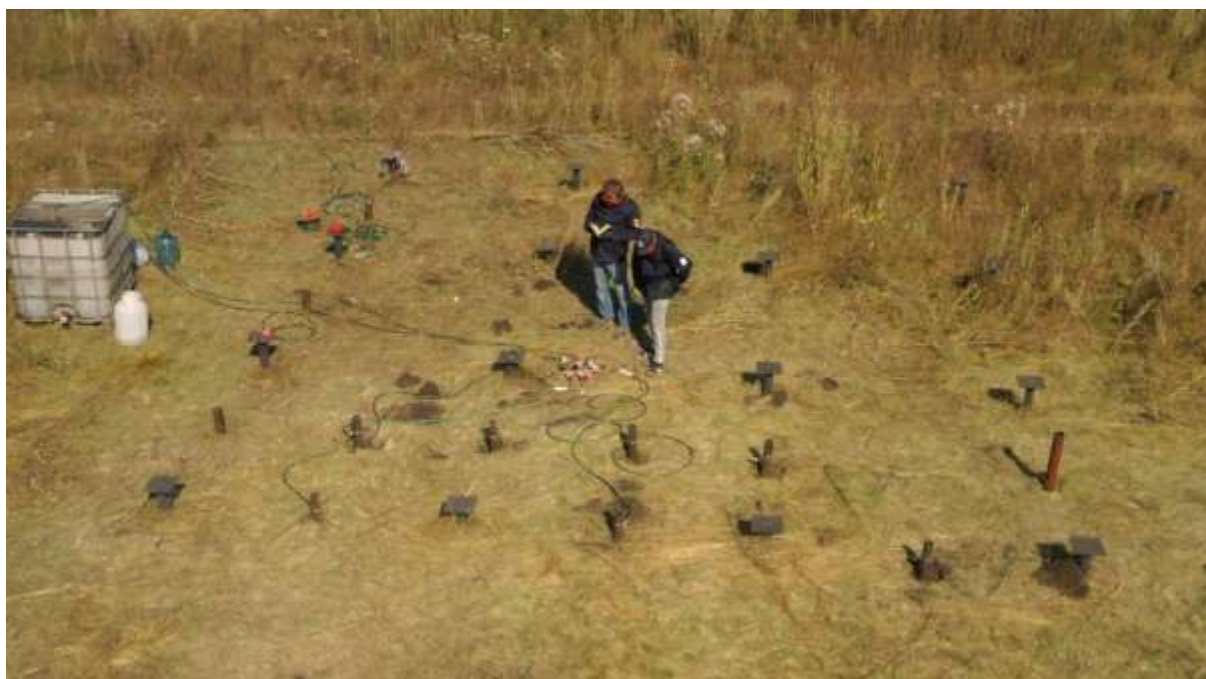
Рисунок 7. Общий вид процесса подачи раствора (фото автора)
