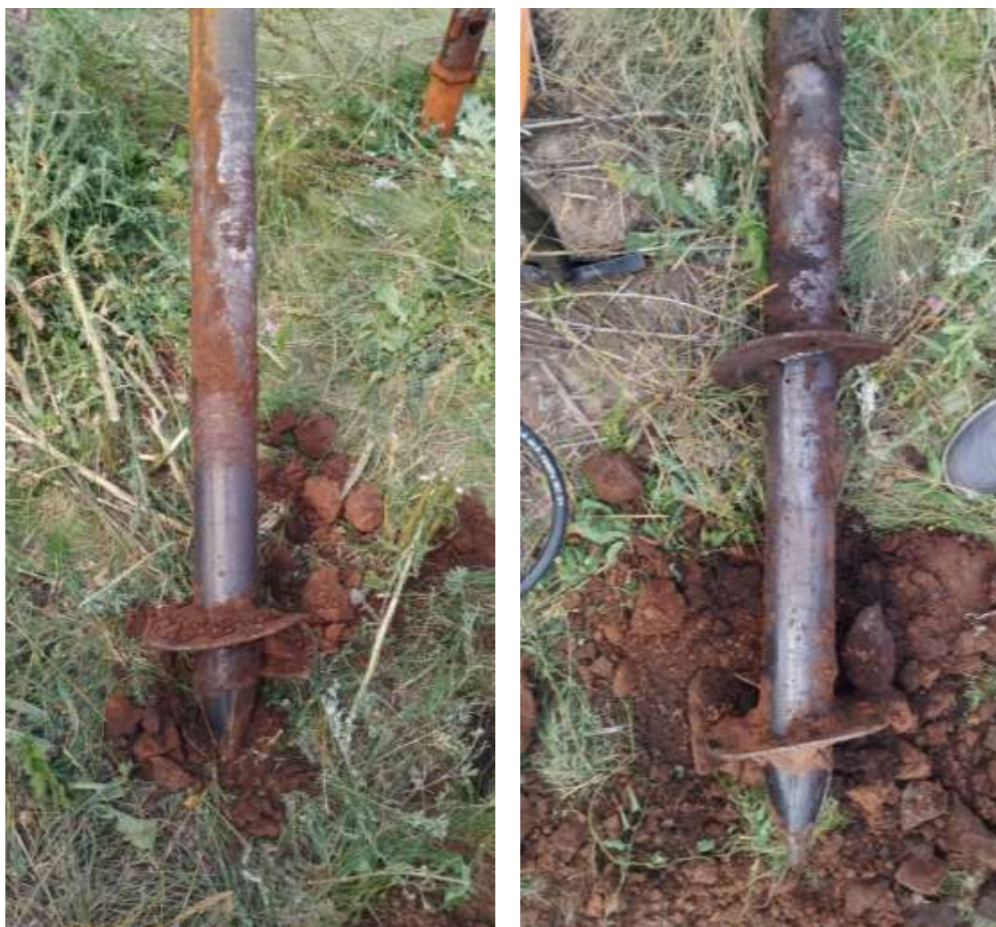
Рисунок 10. Общий вид откопанных свай: слева I–I и справа II–I (фото автора)
