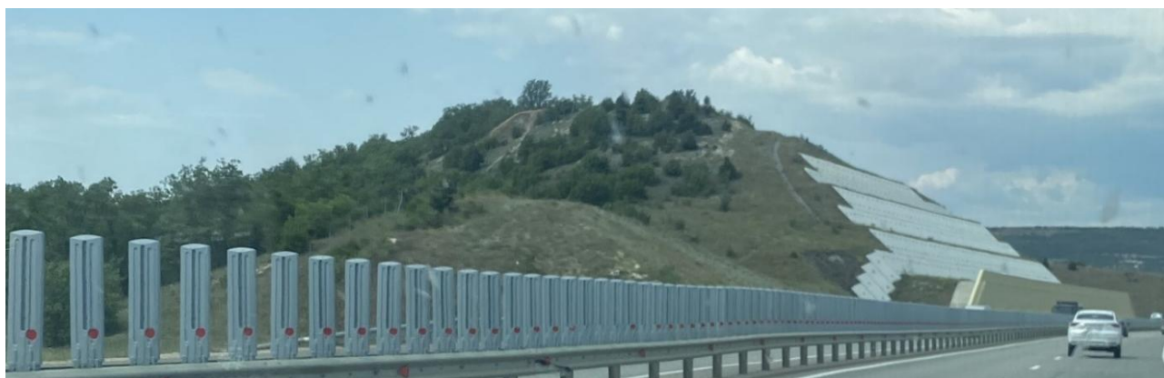
Рисунок 4. Противооползневое сооружение на участке 2 (ПК52 + 22,01 — ПК53 + 95,32) трассы «Таврида» (общий вид) (фото автора)
