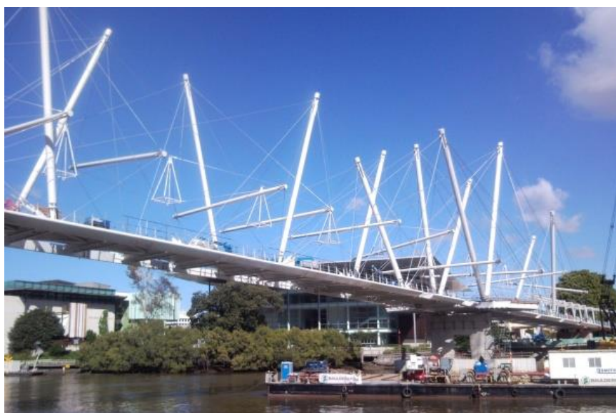
Рисунок 3. Мост Курилпа Бридж (Брисбен, Австралия), выполненный по системе «тенсегрити» [30]
