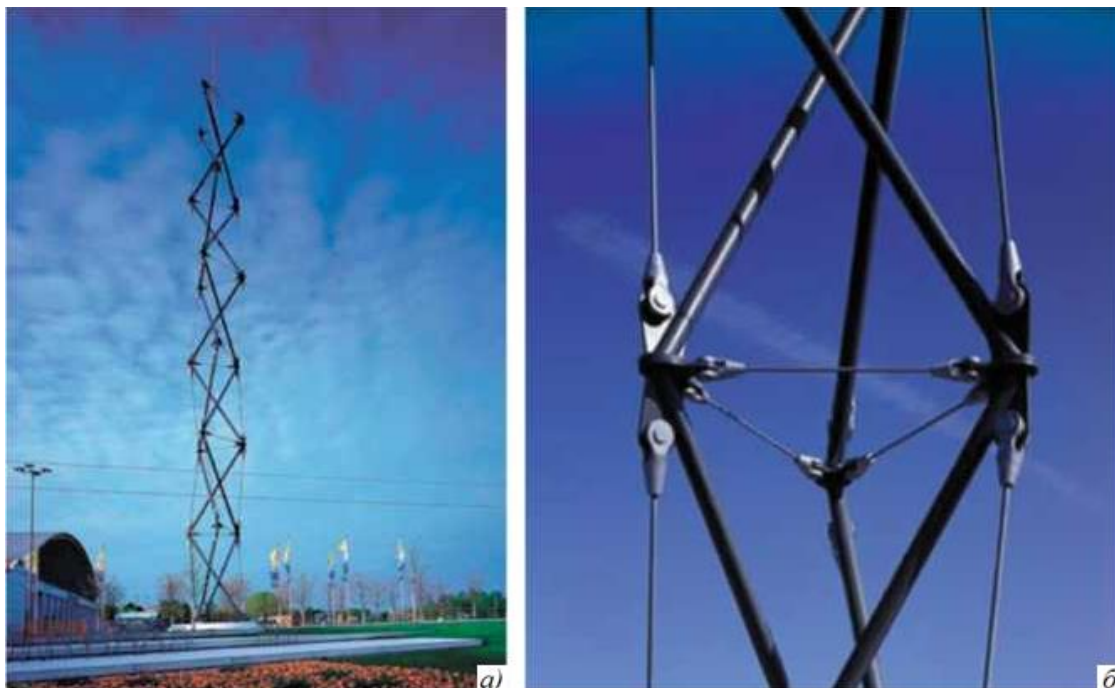
Рисунок 12. Башня Уорноу, где а) общий вид; б) крупный план соединения двух Т-образных призм
