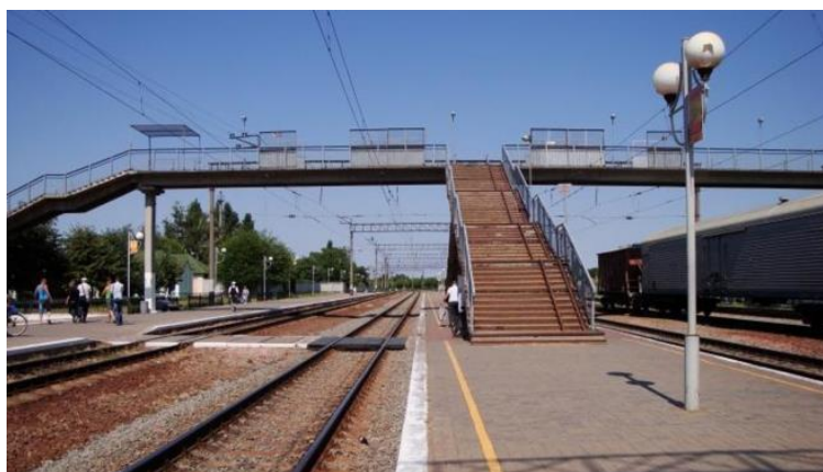
Рисунок 1. Один из «типовых» пешеходных мостов, возведенных в XX веке (фото авторов) Figure 1. One of the "typical" pedestrian bridges erected in the XX century (the authors' photo)
